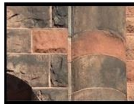
Spalling 88
